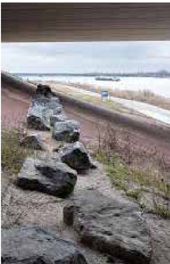
voorbeeld van faunavoorziening met keien in landhoofd onderdoorgang
