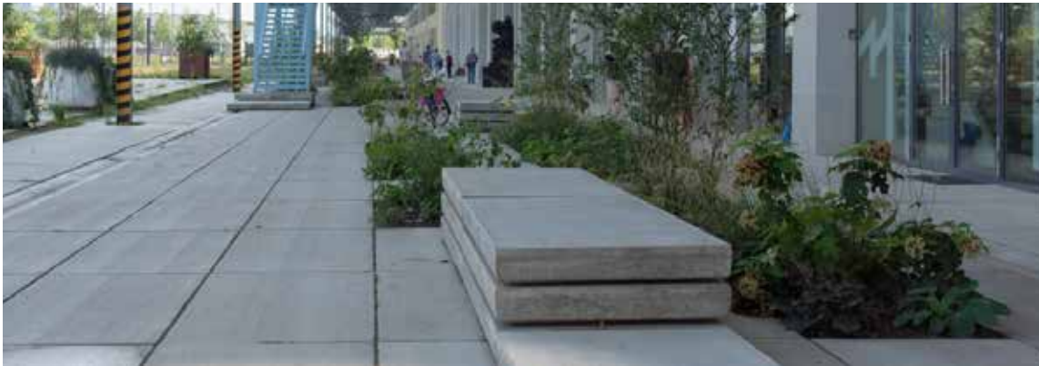
referentie pleinruimte met betonplaten (Strijp-S, Eindhoven)
