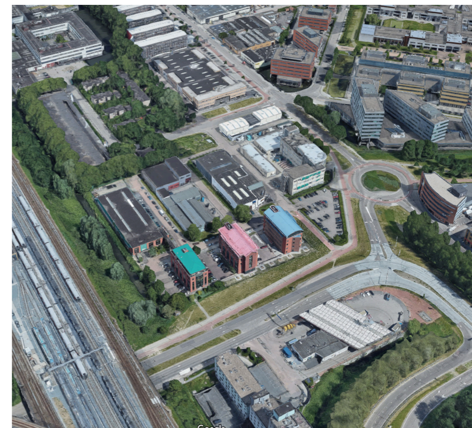
Huidige situatie Wenckebachweg (bron: google .com/maps)
