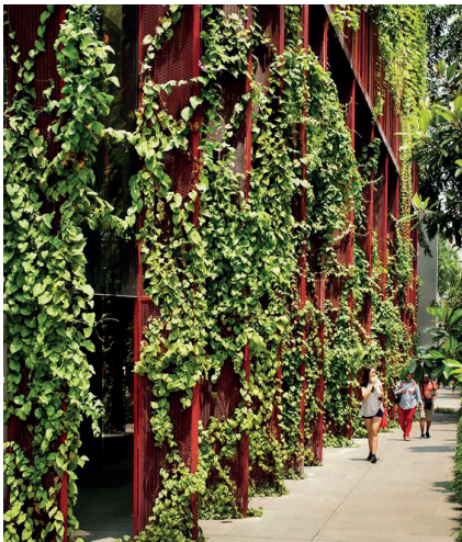
Vergroening van de gevels aan de Schegprikkers en in het binnengebied
