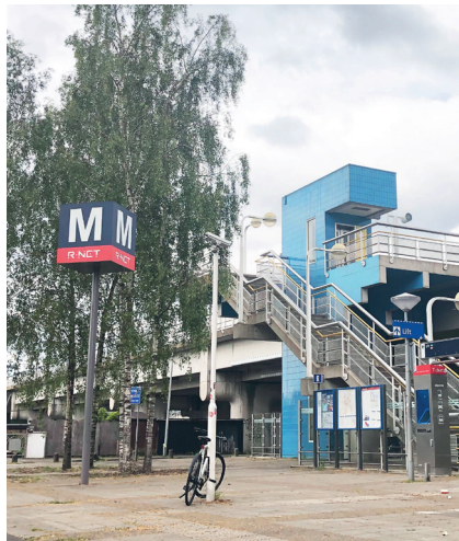
Metrostation Overamstel als herkenbaar oriëntatiepunt
