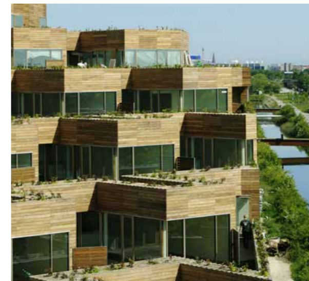
Ruimte voor dakterrassen door trapsgewijze afbouw van het bouwvolume, op lagere daken is ruimte voor daktuinen.
