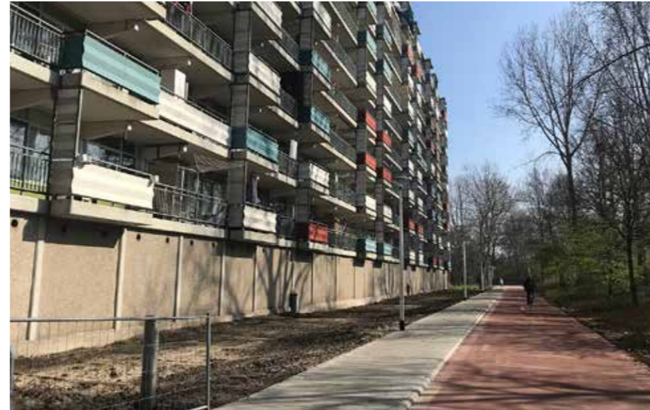
De plint van de Zonnehof draagt niet bij aan een prettig straatbeeld.
