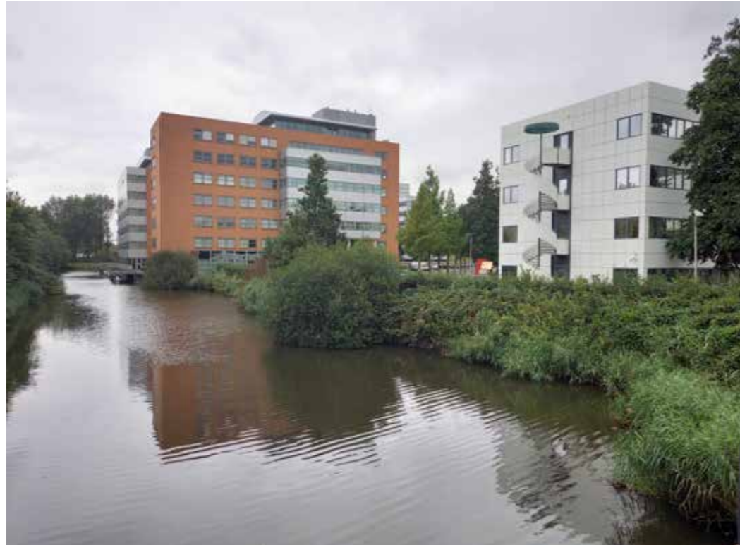
Entree vanaf het metrostation Van der Madeweg
