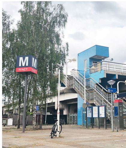
Metrostation Overamstel als herkenbaar oriëntatiepunt
